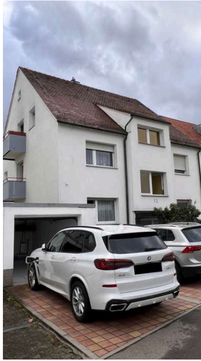
Garage links vom Haus
