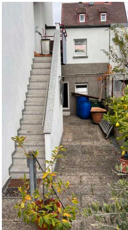
Treppe zur Küche ET
