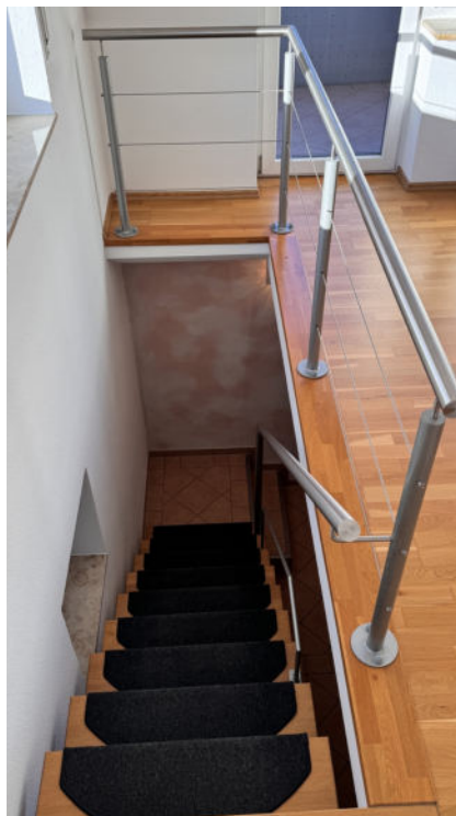
Treppe zum UG
