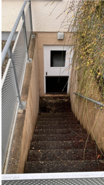
Treppe vom Garten zum Keller UG
